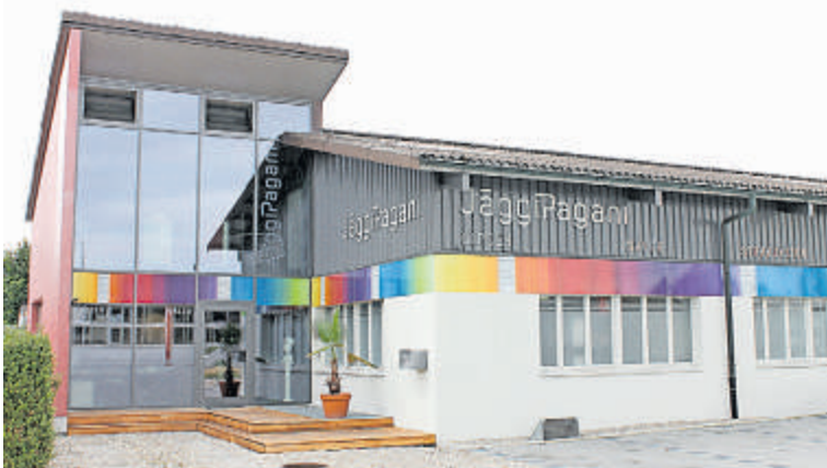
Das Geschäftgebäude mit dem modernen Anbau am Dennliweg 54.
